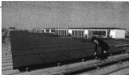
ショッピングセンターの屋上に設置された太陽光パネル 〓二〇〇九年四月、愛知県高浜市で ©朝日新聞
